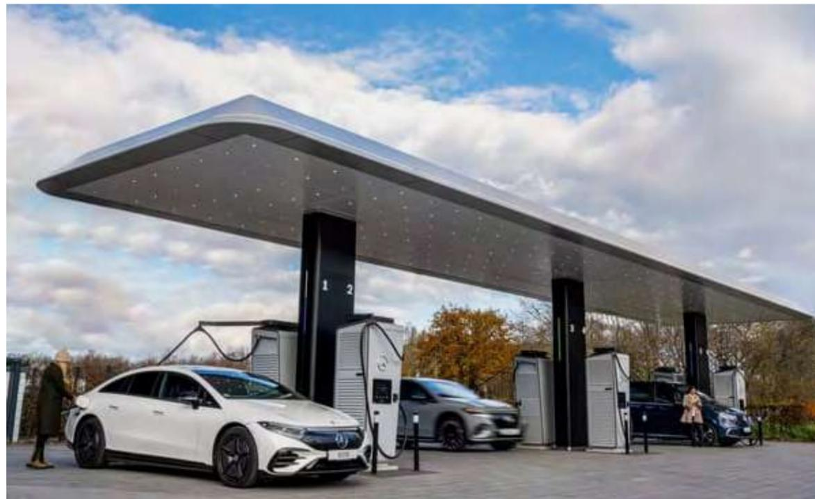
Зарядная станция для электромобилей с шестью устройствами мощностью до 300 кВт расположена в Мангейме (Германия) и эксплуатируется в сотрудничестве с E.ON.
