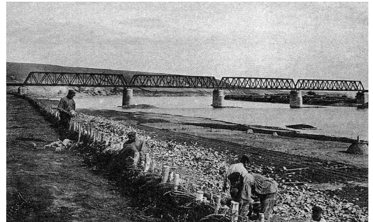
Железнодорожный мост через р. Белая, транссибирская железная дорога
