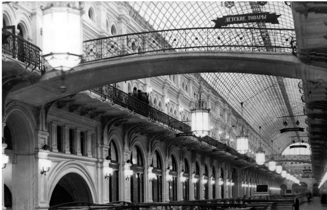
Арочные стальные фермы с остеклением на крыше ГУМа
