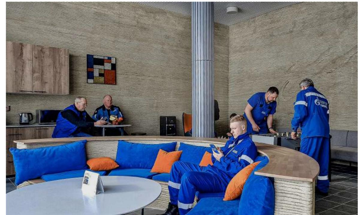
В здании создали зону отдыха для сотрудников производственной базы «Газпромнефть-Снабжения». Строительство с помощью 3D-принтера прошло в 1,5 раза быстрее и в среднем на 30% дешевле традиционных способов.
