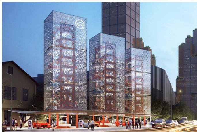
Многоуровневая структура башен позволит заряжать одновременно сразу несколько автомобилей в отличие от стандартных станций. На первом этаже можно будет за 25 минут дозаправить автомобиль на ближайшие 160 километров. Для полной зарядки в течение пяти часов система поднимет машину в отсеки выше — в это время владельцы смогут провести время в городе. В башнях архитекторы совместили зарядные станции с распространенной технологией автостоянок в несколько уровней.
